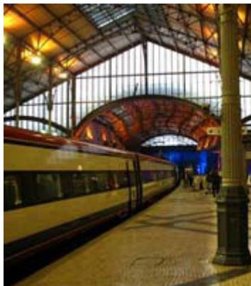
Andenes de la estación.
